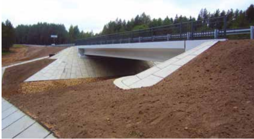
Мост через реку Песка в Торопецком районе
