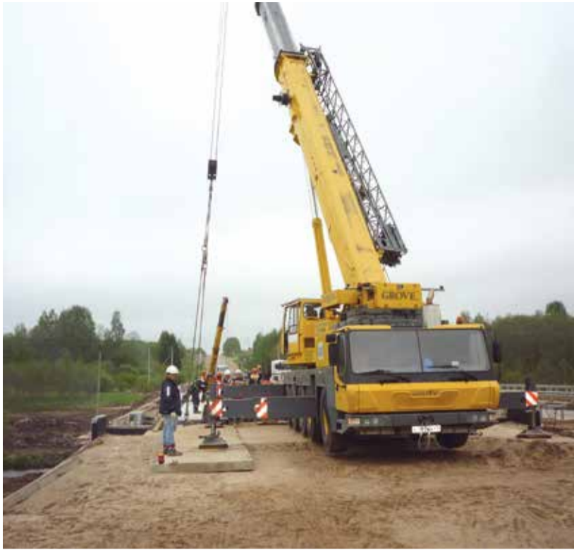
Капитальный ремонт моста через реку Осуга
